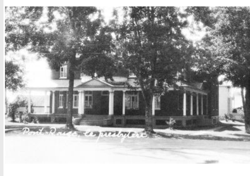
Deuxième presbytère de Pont-Rouge
